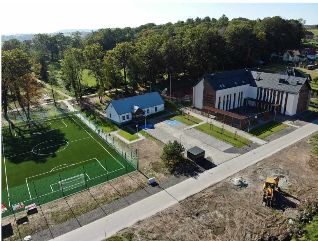
Zdjęcie Centrum Kultury i Rekreacji w budowie, wrzesień 2023 r.
